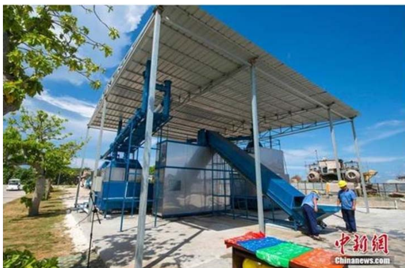
南海三沙岛实际应用现场图
